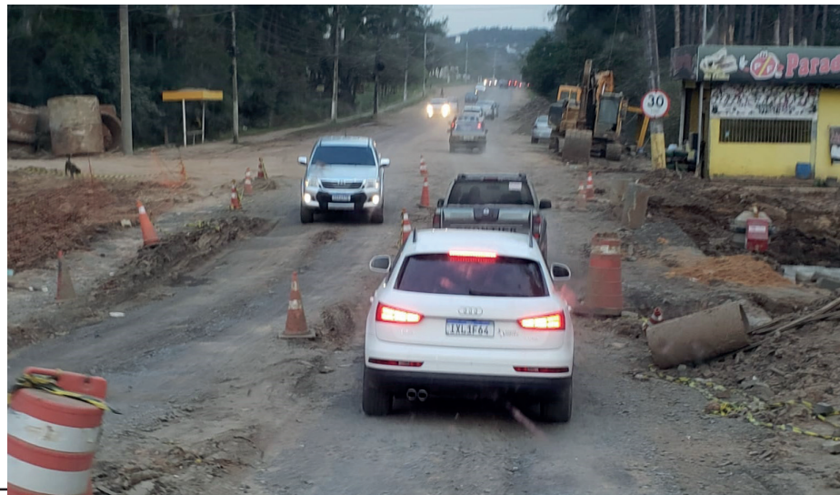
Acesso a Santa Rita seguem as obras. As chuvas tem prejudicando o andamento da reconstrução da travessia.
