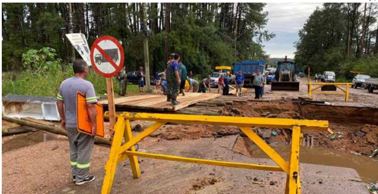
OBRAS: A Secretaria de Infraestrutura instala passagem provisória na Ismael Chaves Barcellos, entre Ipê e Santa Rita.
